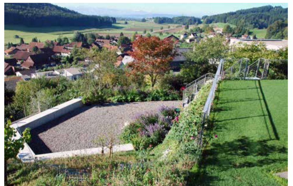
Blick über den «Kieshof» in die Ferne. Der Aufenthaltsort auf der untersten Ebene ist einzig durch eine Sitzmauer aus Sichtbeton begrenzt. Diese dient gleichzeitig als Hangsicherung.
